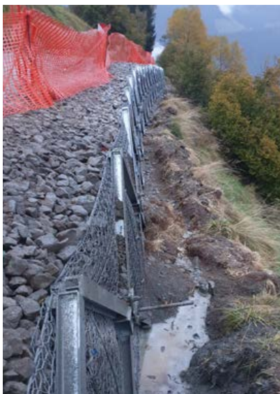
Stabilisierter Unterbau durch Selbstbohranker und Stahlnetze
