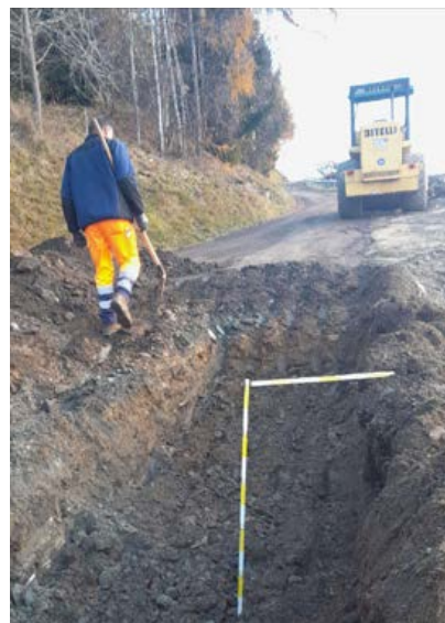
Austausch des Unterbaues
